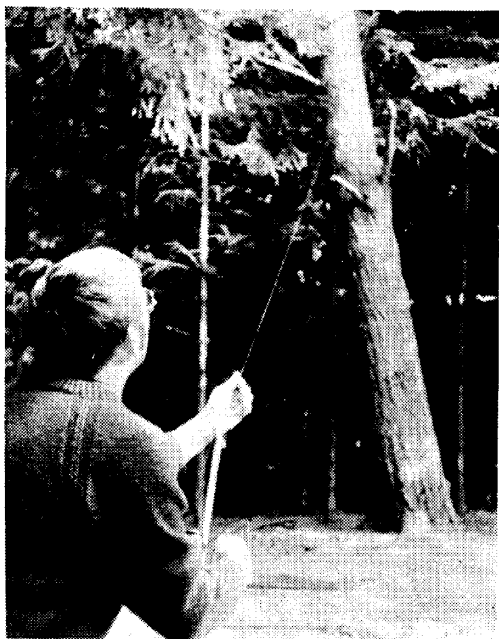
Foto 4: Het binnenhalen van de nylandraad, aan het uiteinde waarvan de trekdraad voor de antenne is bevestigd.
